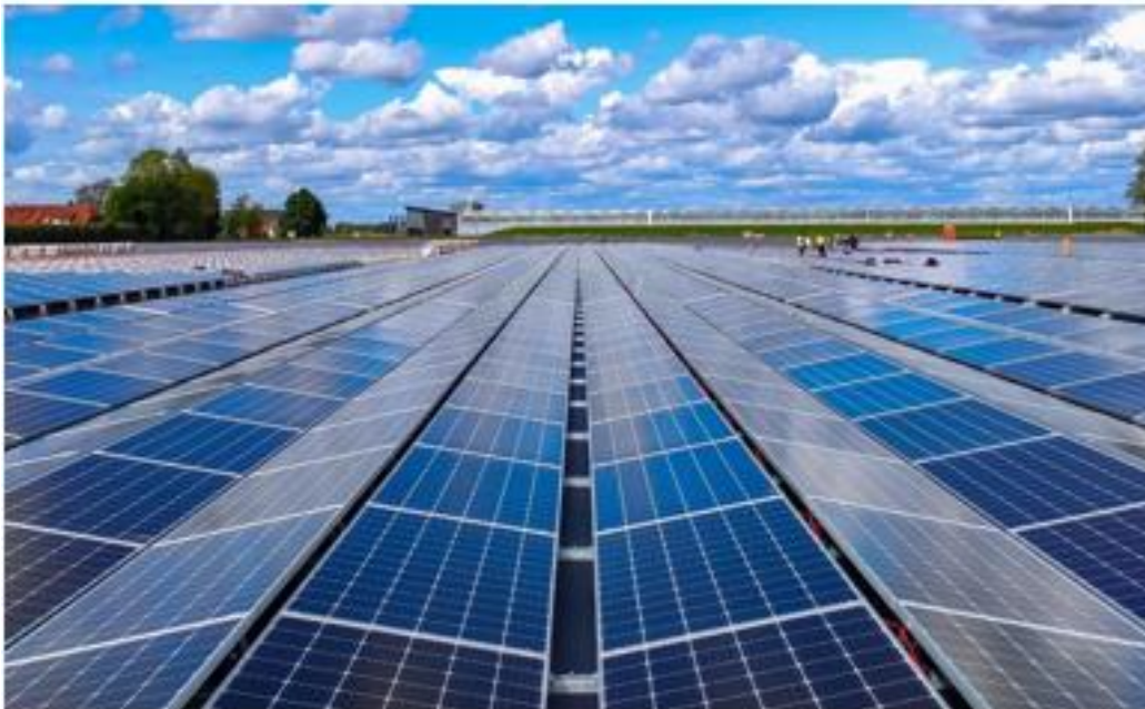
Imagen 14 Instalación de paneles solares para generación de energía
