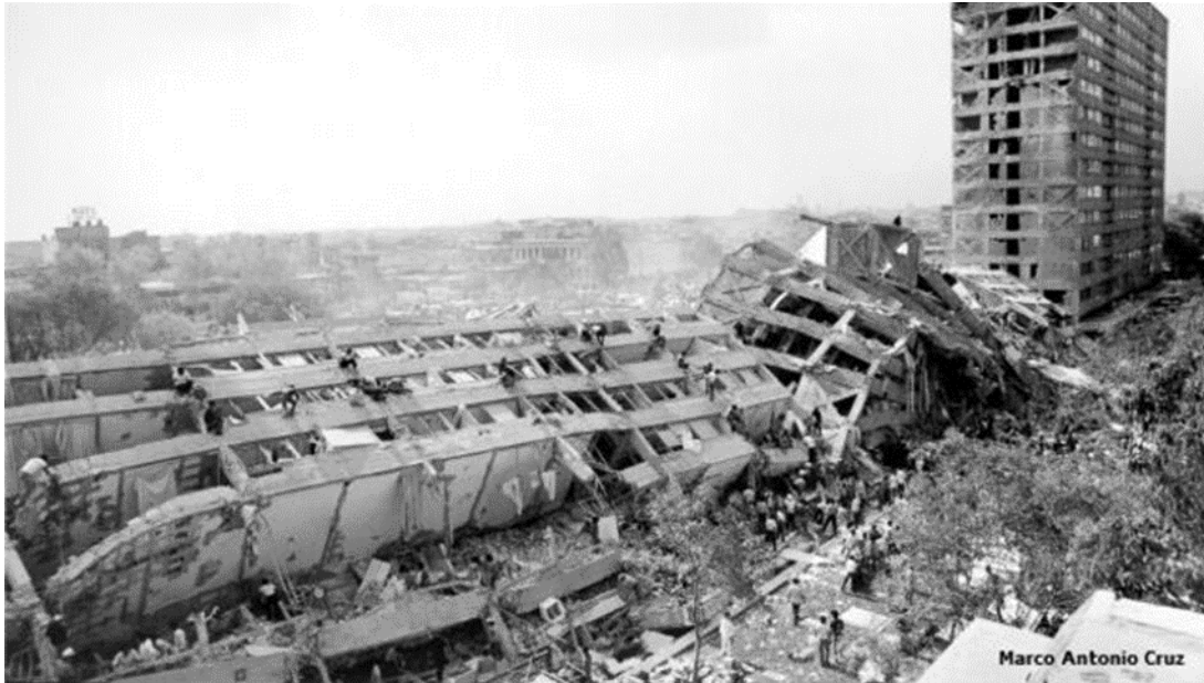
Ilustración 10 Imagen de la Ciudad de México después del terremoto de 1985
