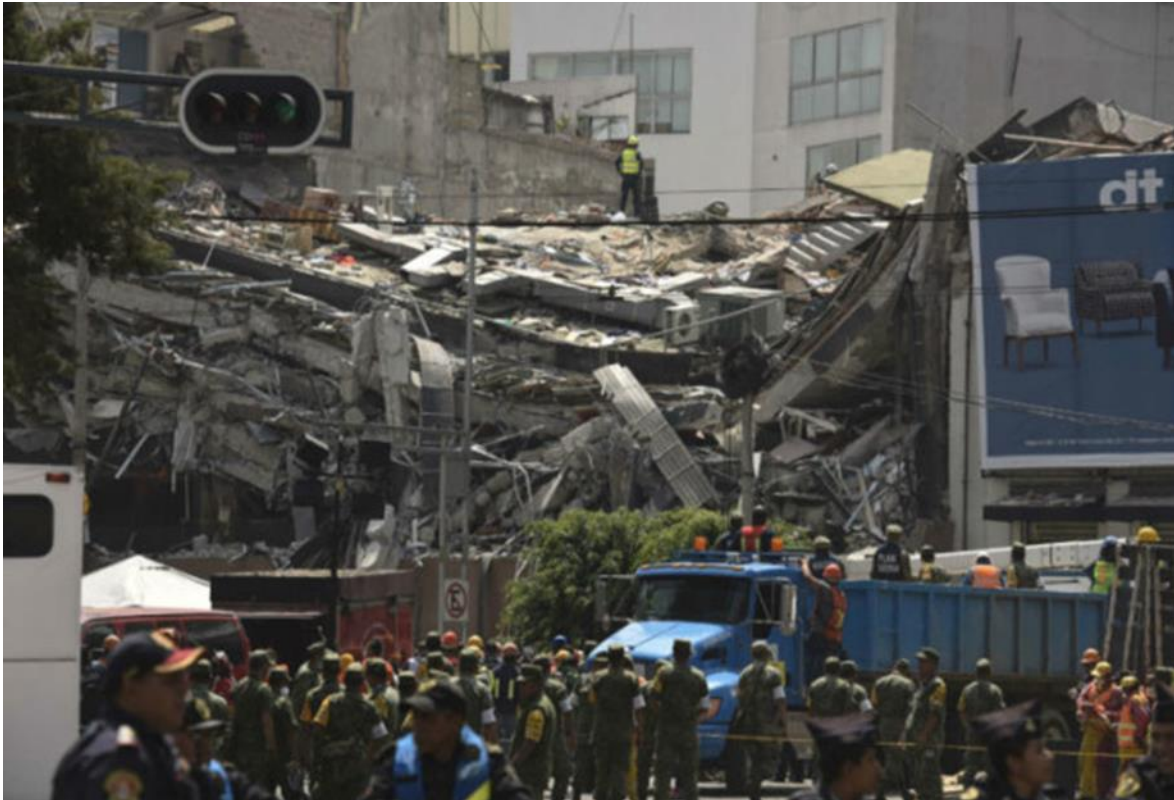
Ilustración 13 Edificio Álvaro Obregón 286 después del sismo del 18 de septiembre de 2017
