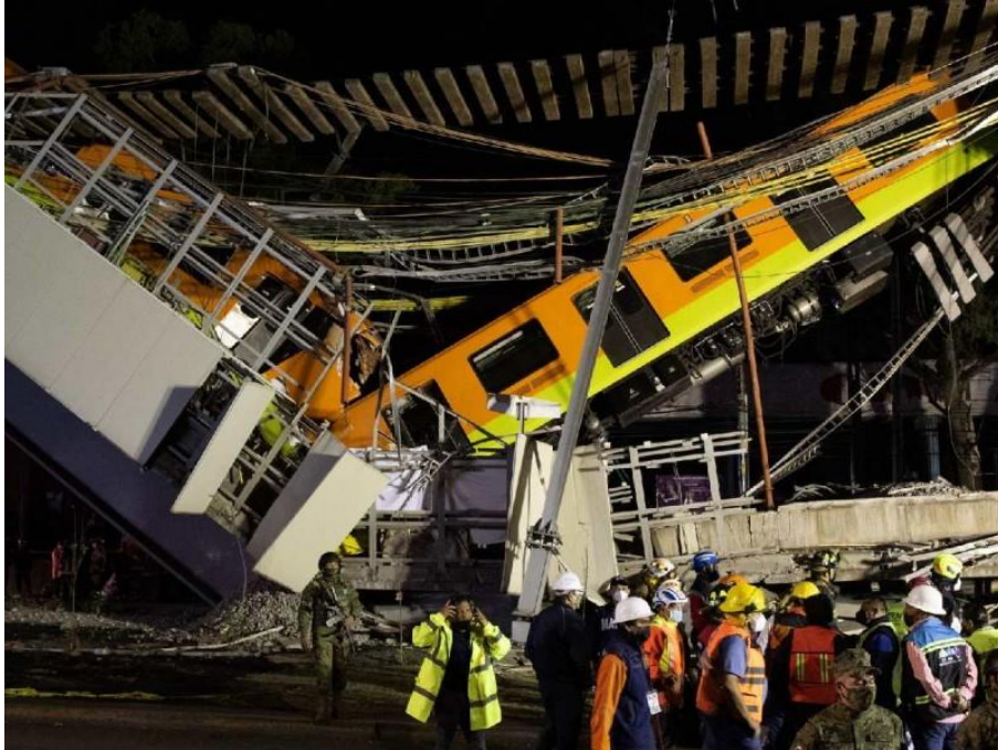
Ilustración 16 Accidente en la línea 12 del metro de la Ciudad de México 2021
