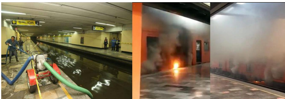
Ilustración 17 Problemas en el metro de la Ciudad de México
