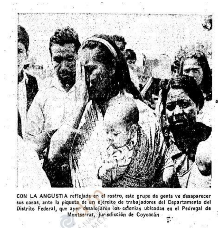
Fig. 14. Testimonios de las familias desalojadas por las obras para ampliar el estacionamiento del Estadio Azteca, 1966
