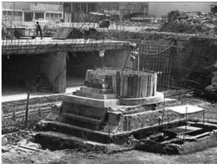
Fig. 26. Basamento del templo dedicado a Ehécatl durante la construcción de la estación Pino Suárez
