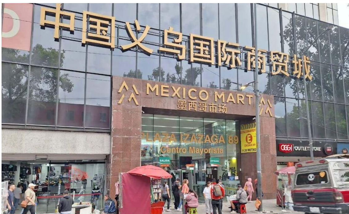
Imagen 4. Fachada del edificio Izazaga 89
