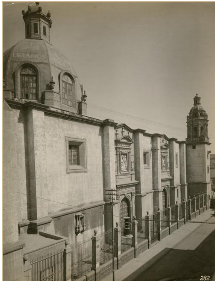
Figura 16. Fachada lateral del exconvento de la Encarnación (1900-1910), Guillermo Kahlo
